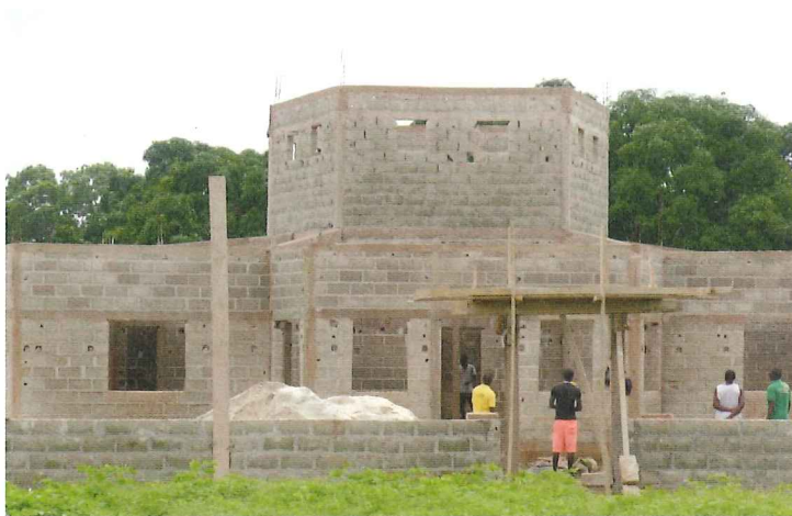
Der Kindergarten-Neubau. Aktuell wird am Dach gearbeitet, danach werden die Innenarbeiten abgeschlossen. Die Eröffnung ist für den 17. Oktober geplant.
